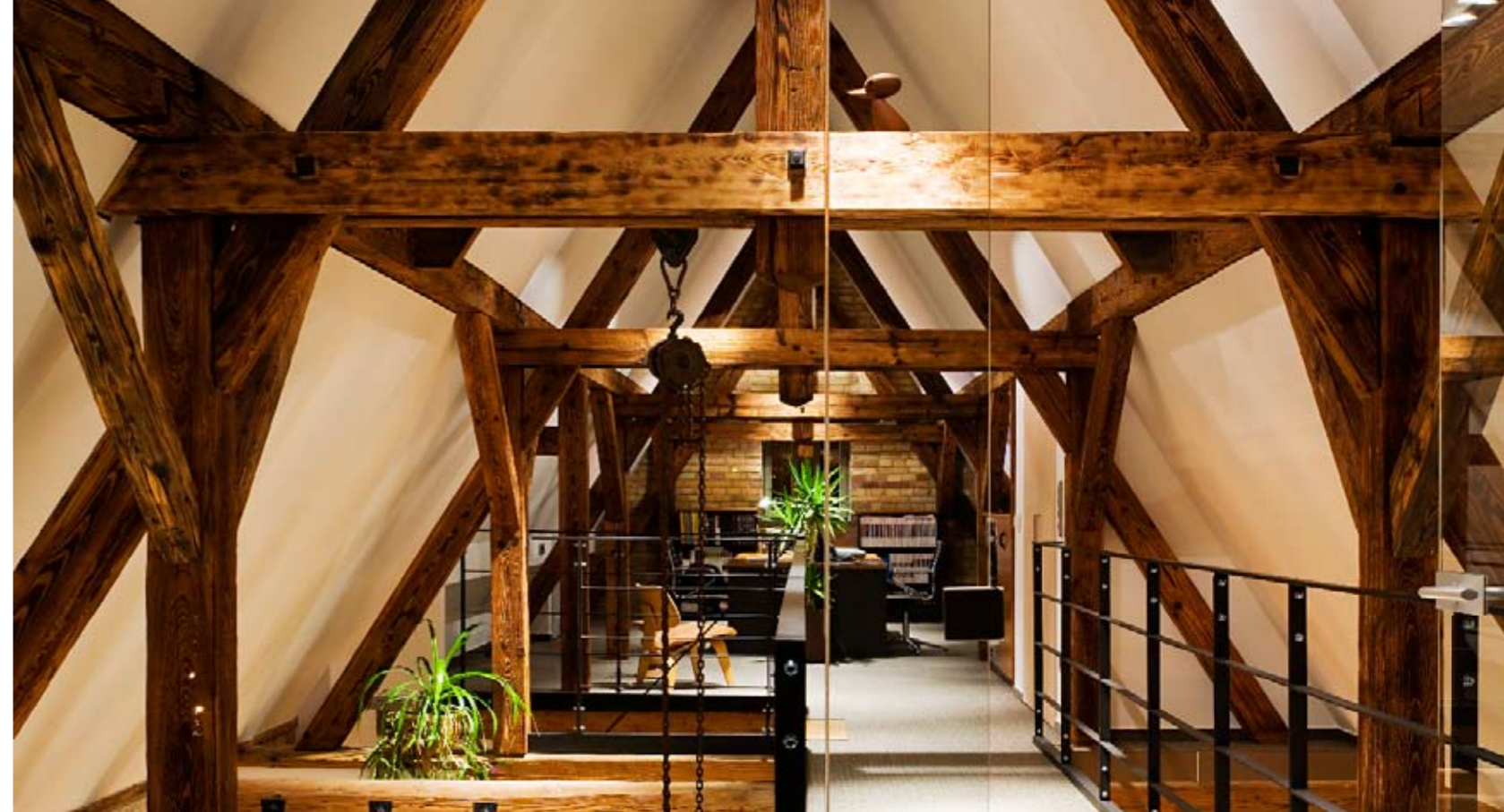
Kiszabadított padlástér: a kétállószerkes fedélszék letisztított gerendáinak gyönyörű struktúrája
